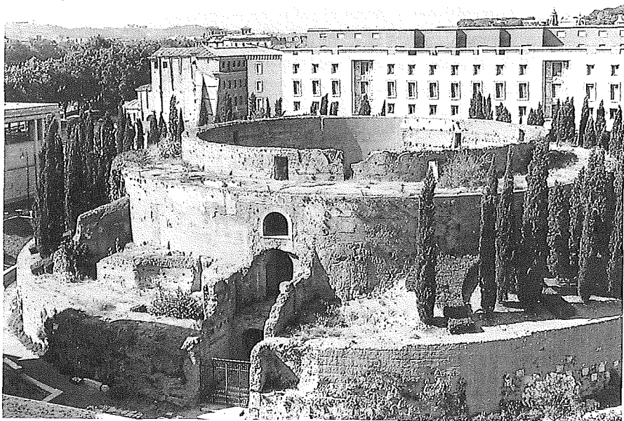
57. Roma, Mausoleo de Augusto. Ruina en el estado actual, con las edificaciones fascistas al fondo.
