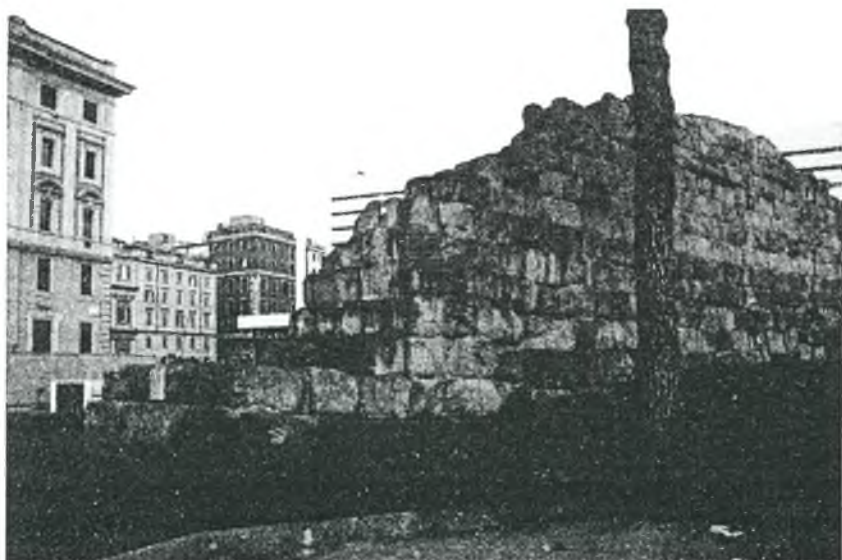
FIGURA 31. Roma: Los «muros servianos».
