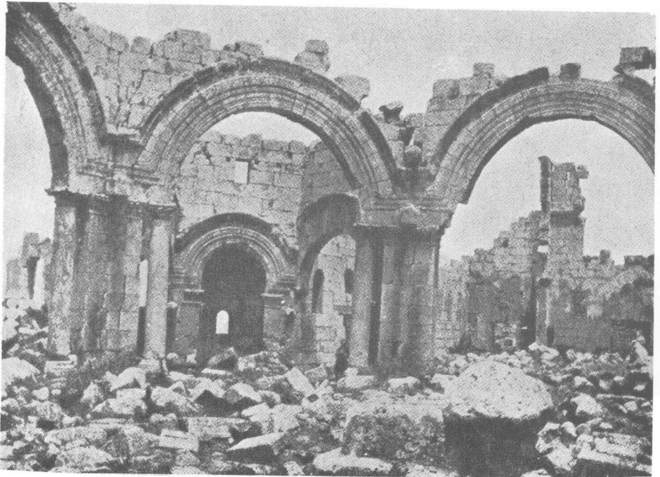
Arriba: El monasterio de San Simeón Estilita (Kalat Siman) Abajo: Patio octogonal con los restos de la columna sobre la cual hizo penitencia el santo
