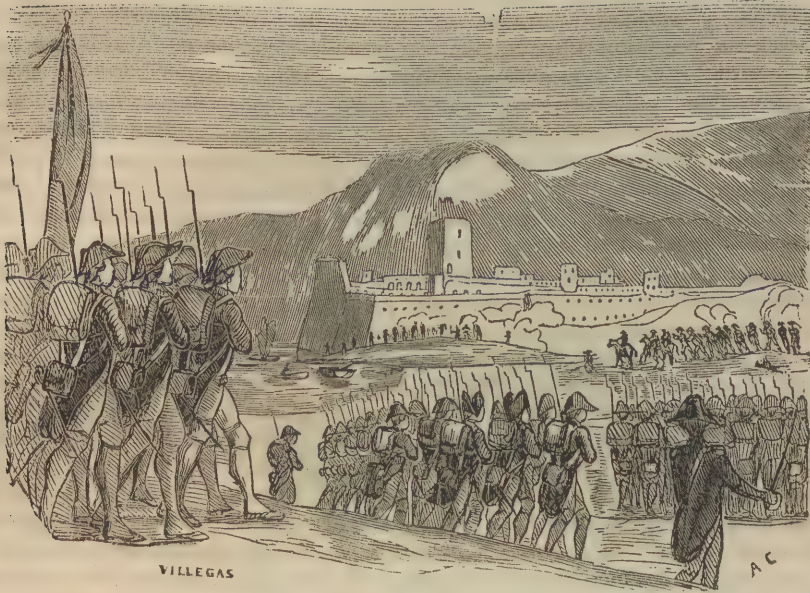
PÉRDIDA DE ROSAS.
