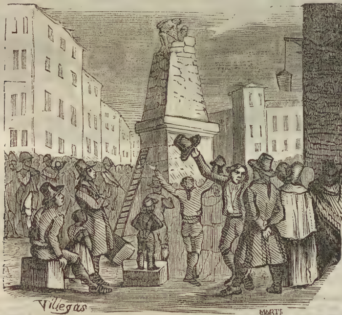
DERRIBO DE LA PIRÁMIDE DE RONCESVALLES.
