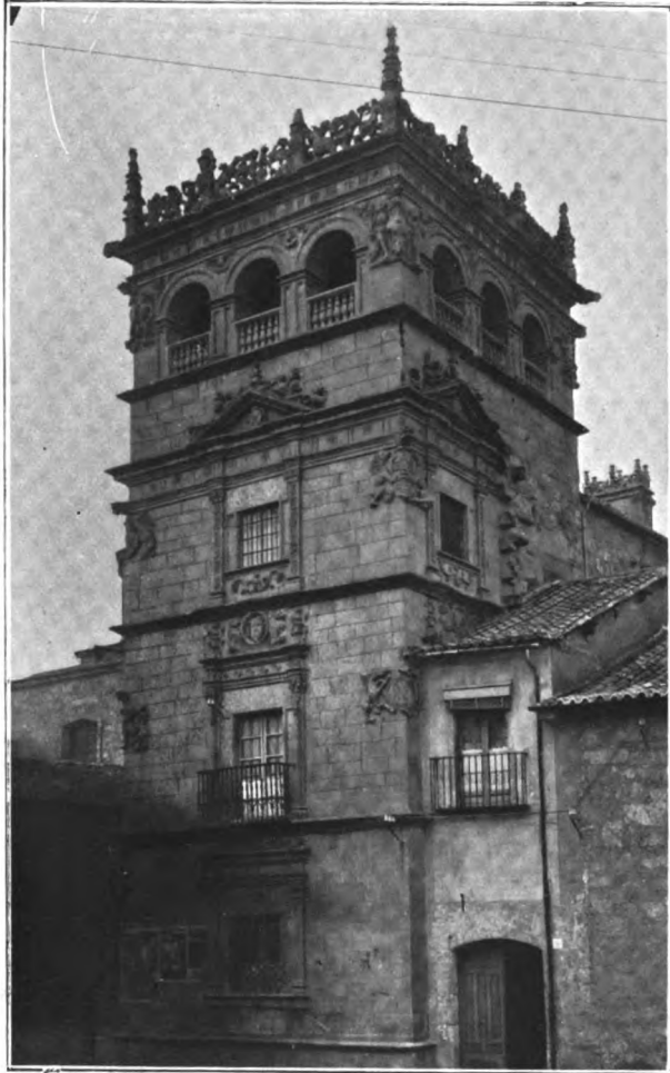
Fig. 327. — Torre del palacio de Monterrey. SALAMANCA.
