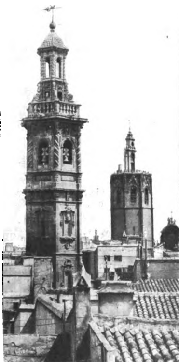
Fig. 490. — Torre de Santa Catalina. VALENCIA.
