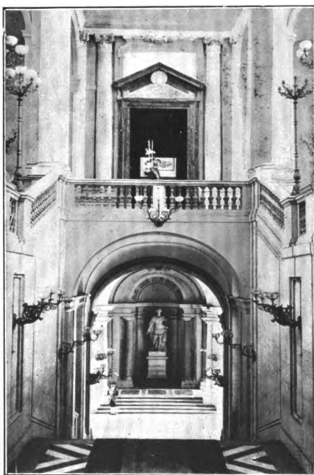
Fig. 500. — Escalera del palacio real. MADRID.
