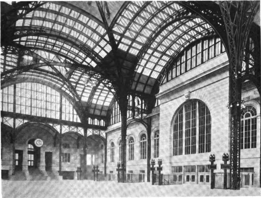
Fig. 664. — Vestibulo de la estación de Pensilvania. NUEVA YORK.
