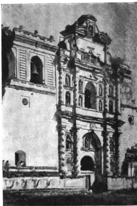
Fig. 522. — Ruinas del convento de San Francisco, en la Antigua, México.
