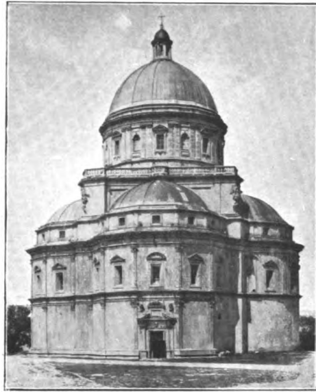
Fig. 185. — Iglesia de Santa María de la Consolación. Todt.
