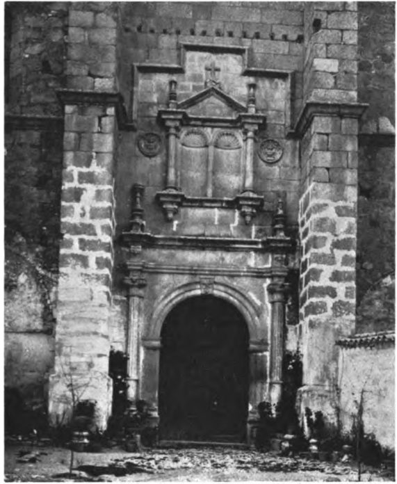
Fig. 331.— Fachada del convento de frailes de Escalona de la Albercha. TOLEDO.
