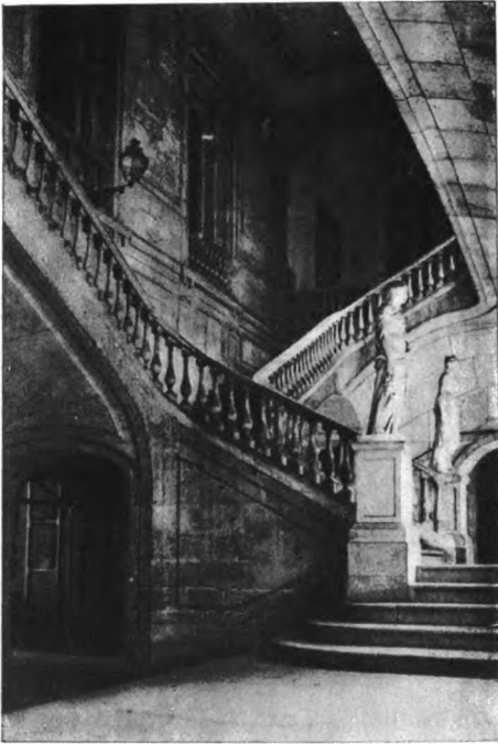
Fig. 638. — Escalera de la Lonja. BARCELONA.
