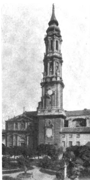
Fig. 489. — Torre de la Seo. ZARAGOZA.
