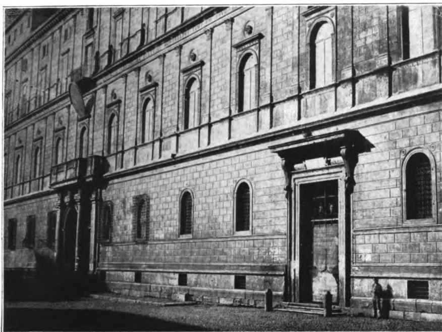
Fig. 83 — Fachada del palacio de la Cancillería. ROMA.
