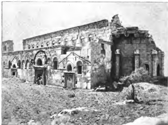
Fig. 84. — Una de las naves del Kalat-Simaan ó convento de San Simeón. Siria.
