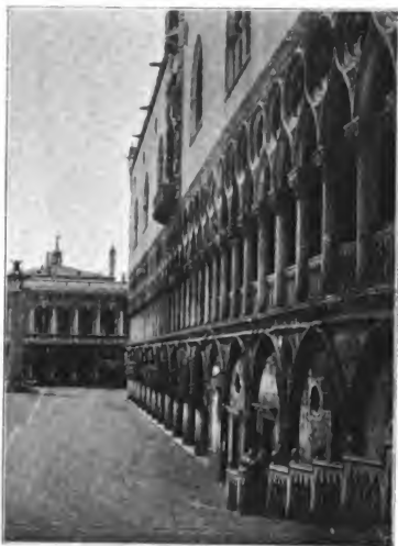
Fig. 718 — Fachada lateral del palacio ducal. VENEZIA.
