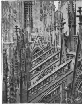
Fig. 768.— Contrafuertes de la catedral de Colonia.
