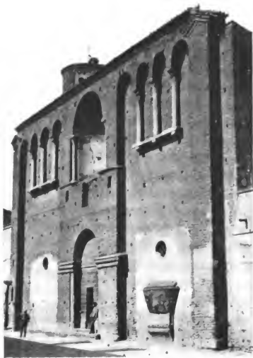
Fig. 226. — Fachada del palacio de Teodorico (antes de la restauración). RÁVENA.
