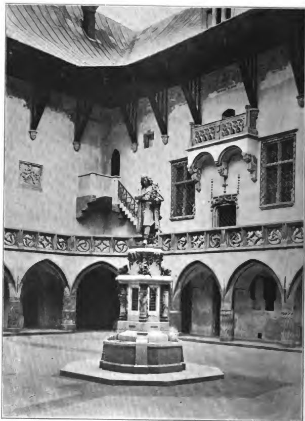
Fig. 780. — Patio de la antigua Universidad de Cracovia. POLONIA
