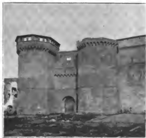
Fig. 654. — Puerta real. PONTRET.
