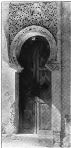
Fig. 314.—Puerta de la Aljafería. ZARAGOZA
