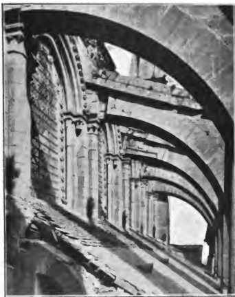
Fig. 560.—Contrafuertes. Catedral de Laón.
