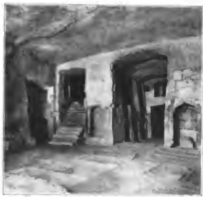
Fig. 29. — Catacumbas de San Jenaro. NÁPOLES.
