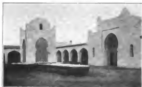
Fig. 337. — Patio principal del palacio del Sultán. Fez
