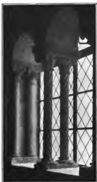
Fig. 544. — Ventanas de la sala capitular. Fossanova .
