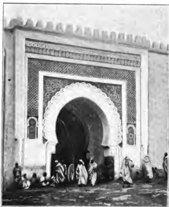
Fig. 345. — Una puerta de las murallas de Fez.
