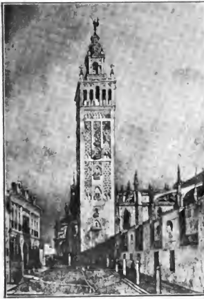
Fig. 323. — La Giralda antes de la última reforma. SEVILLA.
