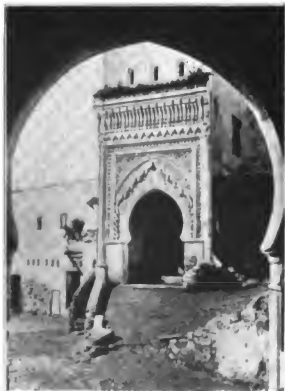
Fig. 342. — Interior de la puerta de Ceuta. TETUÁN.
