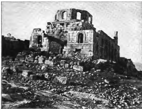
Fig. 71. — Construcción octogonal en el monasterio de San Simeón. Kalaat Simaan . SIRIA.
