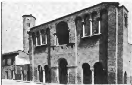
Fig. 228. — El palacio de Teodorico. Estado actual. RÁVENA.
