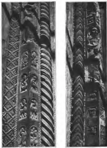
Figs. 476 y 477. — Detalles de las jambas de la puerta principal. Catedral de Ferrara.
