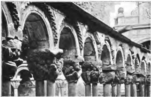
Fig. 406. — Arcos del claustro del monasterio de San Juan de la Peña.
