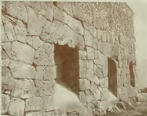
Fig. 571. — Muros de la Acrópolis latina de Alatri.
