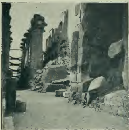
Fig. 103. — Trabajos de consolidación en Karnak. Andamiadas de la sala hipóstila. ( Clisé Junyent )
