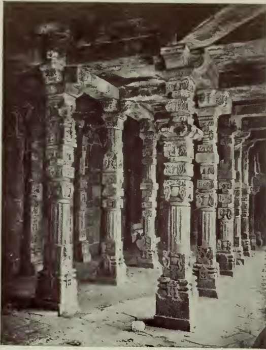
Fig. 227. — Sringam. Construcción de piedra imitando un techo de madera.
