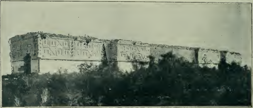
Fig. 801. — Ruinas de la llamada Casa del Gobernador . UXMAL.
