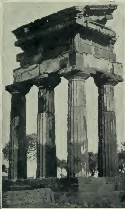
Fig. 309. — Templo dórico con el estuco de revestimiento para la pintura. AGRIGENTO.
