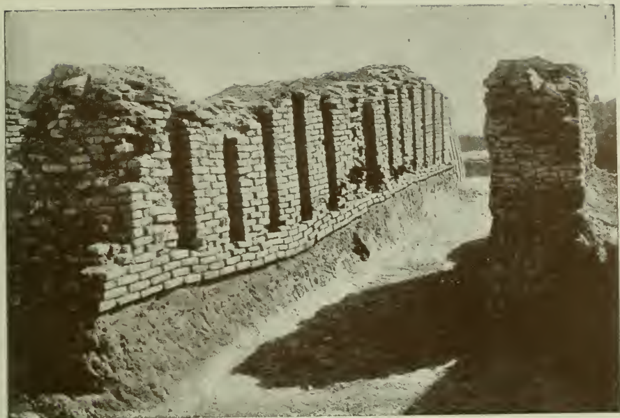
Fig. 144.— Fachadas del palacio de Sarpula, con sus paramentos estriados. ( Sarzec-Heuzey ).
