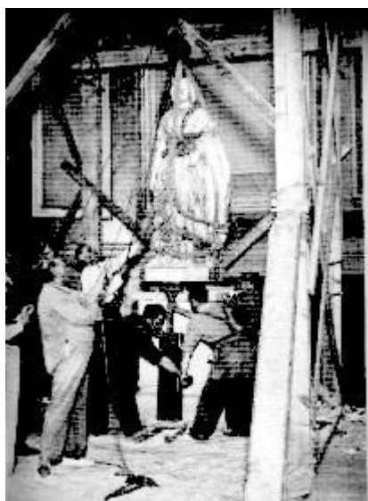
La estatua de Isabel II, descendida de su pedestal, para ser trasladada
