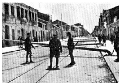
Valencia. Tumban los postes eléctricos
