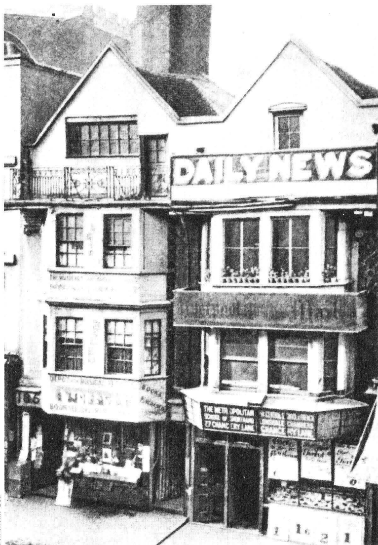
Las antiguas oficinas del Daily News en Fleet Street, antes de ser demolidas.
