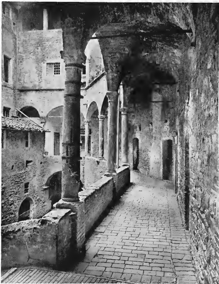
STAIRWAY LEADING FROM THE PIAZZA DEGLI ARATRI TO THE CANONICA
