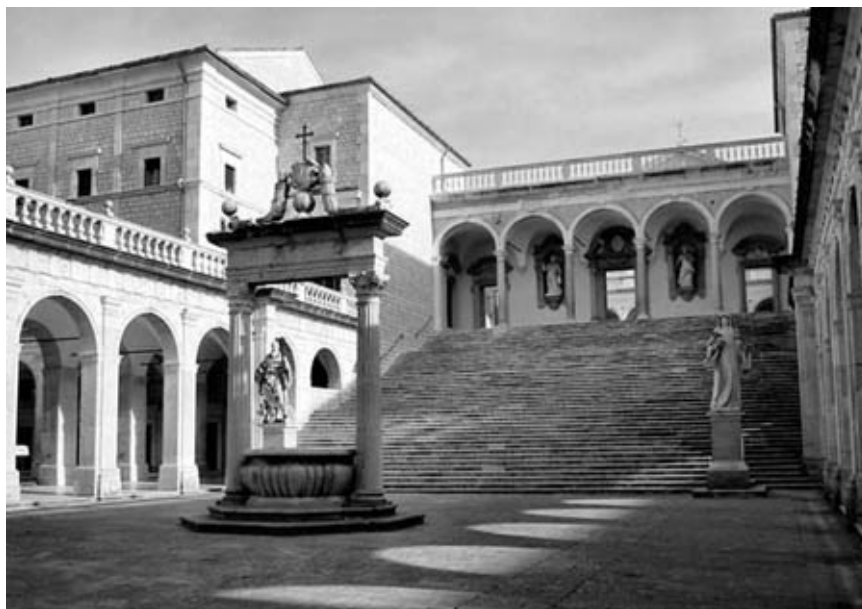
La abadía de Montecassino en la actualidad, reconstruida meticulosamente después de ser reducida a escombros por los bombarderos aliados en 1944.
