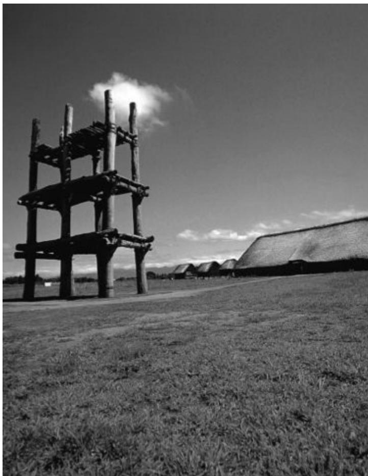
Reconstrucción de uno de los grandes edificios de postes de madera del yacimiento de Sannai Maruyama
