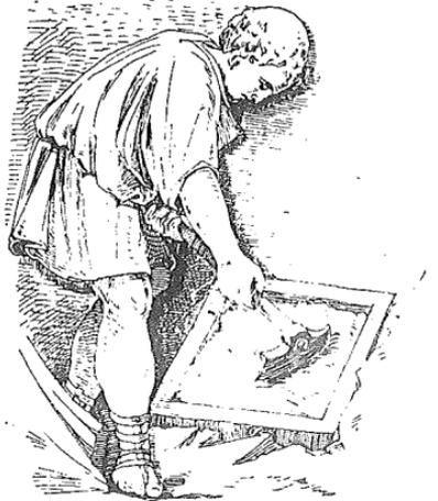
Fig. 139. — Un albañil («structor») preparando mortero. (Relieve de la Columna Trajana).
