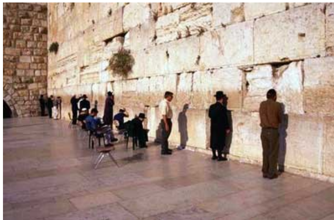
El "muro de los lamentos".
