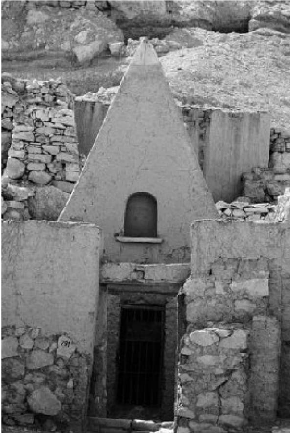
Figura 11.6. Pirámide de ladrillo de la necrópolis de Deir el-Medina. Reino Nuevo (foto del autor).
