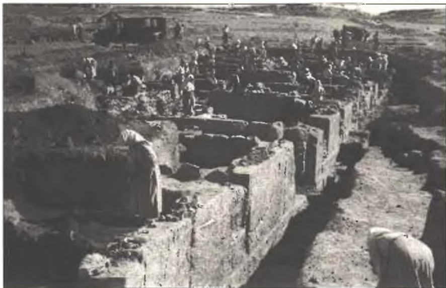
FIGURA 3.1. Fachada del edificio 18 de Enkomi, el más grande e imponente, posible residencia oficial del «príncipe».
