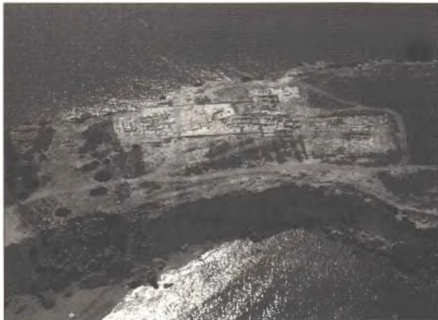
FIGURA 4.5. Vista aérea de las excavaciones de Maa Palaeokastro . A la izquierda se aprecian las fortificaciones ciclópeas.
