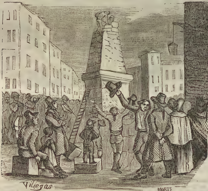
DERRIBO DE LA PIRÁMIDE DE RONCESVALLES.
