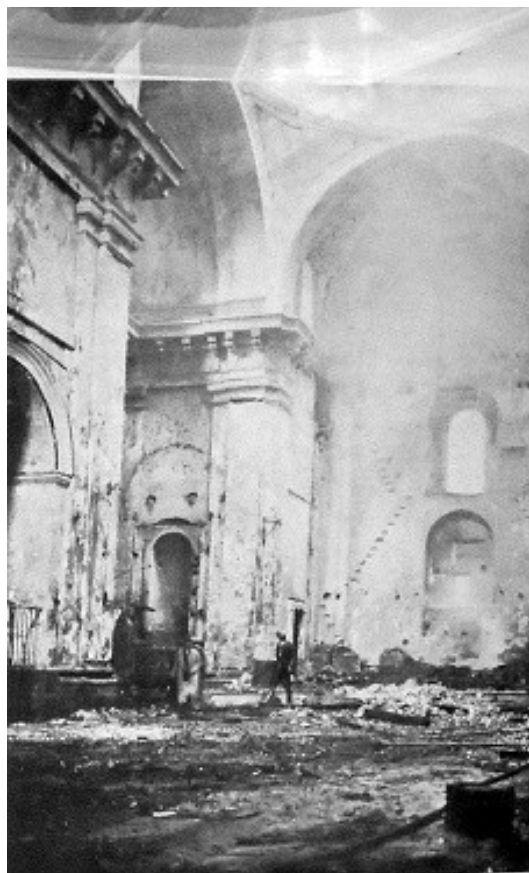
Interior de la iglesia de San Luis después del incendio
