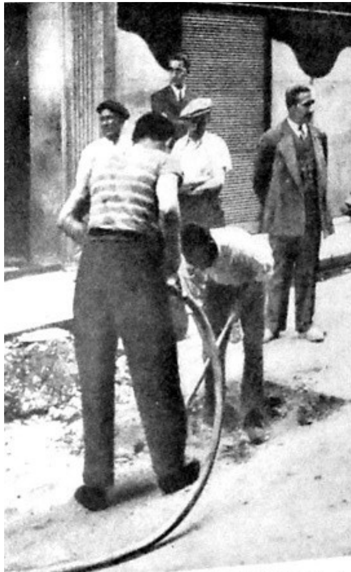
Obreros reparan en Madrid unas tuberías de la conducción de agua, protegidos por la policía
