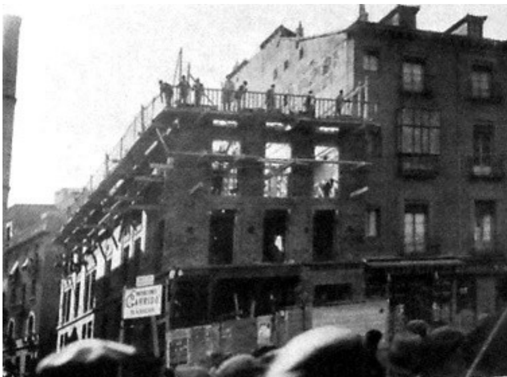
Huelguists ocupan una casa en construcción para impedir la reanudación del trabajo
