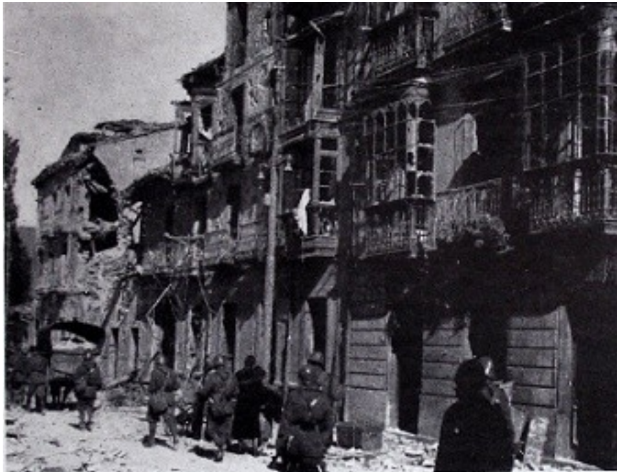
Calle contigua al Instituto Nacional de Segunda Enseñanza, muestra los efectos de la voladura de éste
