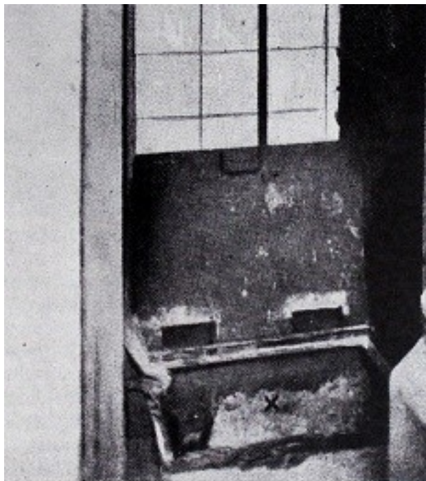
Boca de la alcantarilla por donde huyeron Dencás y otros jefes de la sedición
