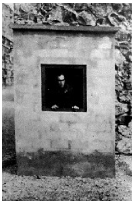
Garita construida en el cementerio para vigilar la tumba de Maciá
