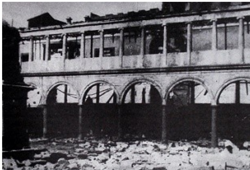
Patio de la Universidad después del incendio
