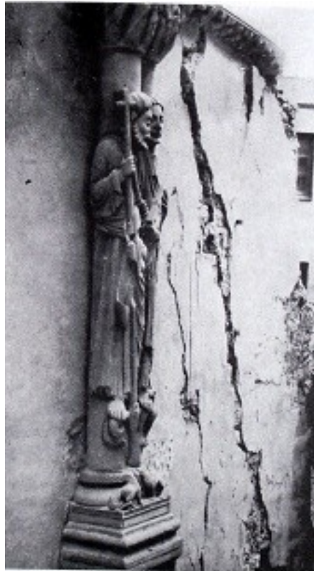
Efectos de la explosión en la parte no derrumbada de la Cámara Santa
