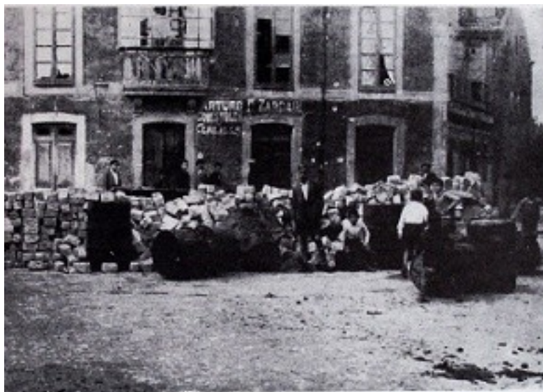
Barricadas levantadas por los sediciosos en el barrio del Llano en Gijón
