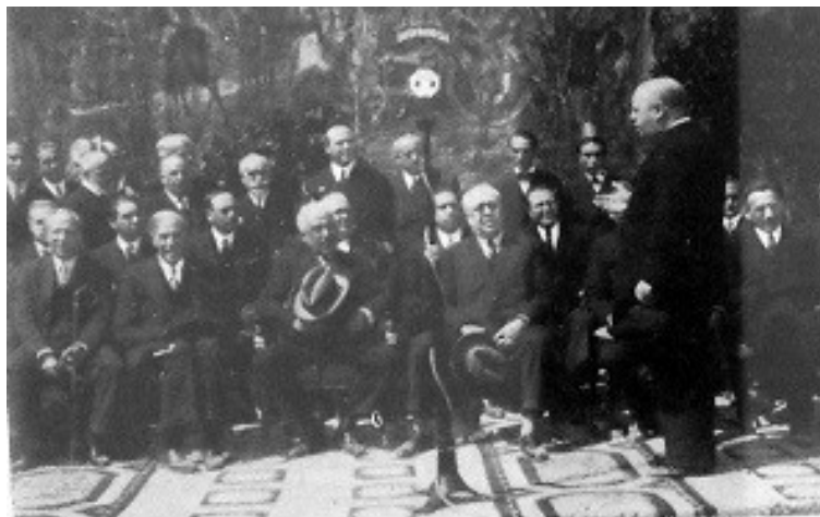
Inauguración de las obras de los nuevos Ministerios
