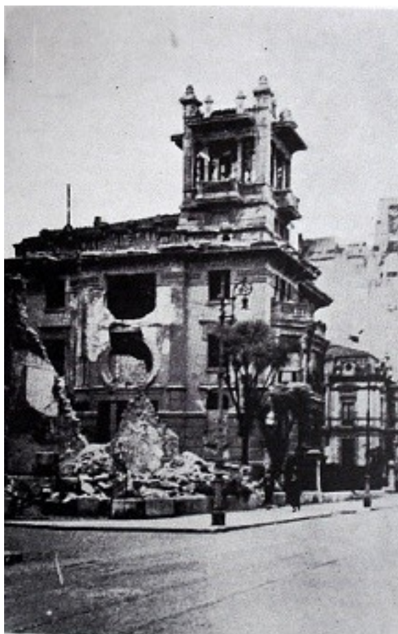
Destrozos causados por la dinamita en edificios de la calle de Uria
