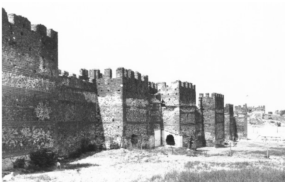
4. Las murallas de la ciudadela de Tesalónica, probablemente construidas a mediados del siglo V, con más de veinte puertas y un centenar de torres, vistas desde el lado norte.
