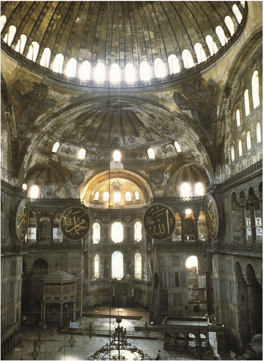
18. Interior de Santa Sofía donde se aprecia el extremo oriental y la cúpula, con invocaciones musulmanas en los escudos que cuelgan al nivel de las galerías, donde apenas resultan visibles los mosaicos imperiales. Por encima, las pechinas, decoradas con mosaicos del siglo VI de serafines (criaturas aladas con rostro), sostienen la cúpula en las cuatro esquinas de su base.
