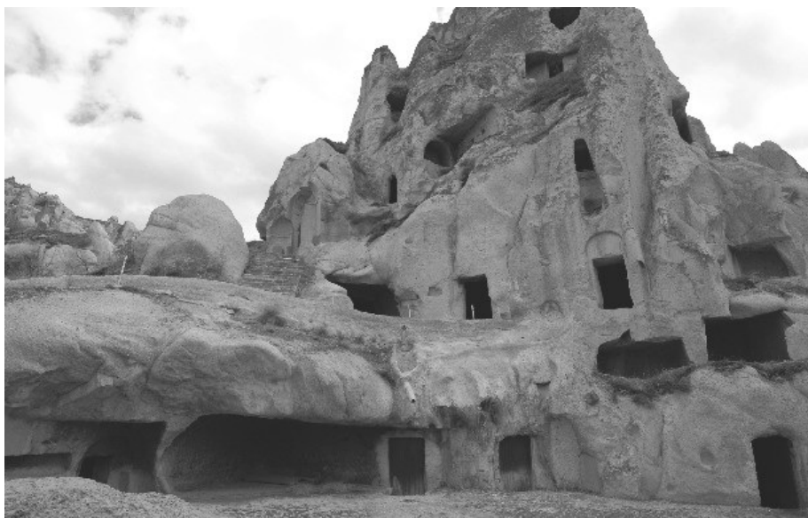
12. Karanlık Kilise, Capadocia, Turquía, iglesia rupestre del siglo XI-XII de esta región permitía que se excavaran iglesias, monasterios y viviendas, creando estructuras subterráneas que se mantienen calientes en invierno y frescas en verano.
