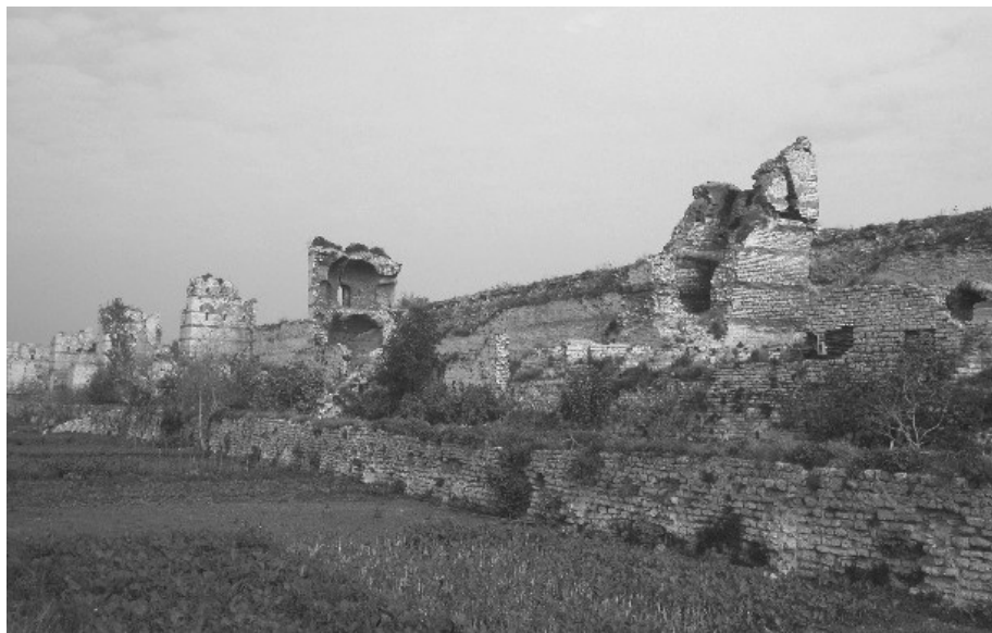
3. Las murallas terrestres de Constantinopla, una triple línea de defensa completada en 413 bajo el reinado de Teodosio II, vistas desde el lado oeste; puede apreciarse el foso (hoy cubierto) y la muralla exterior, la muralla intermedia con sus torres y la muralla interior con sus torres.
